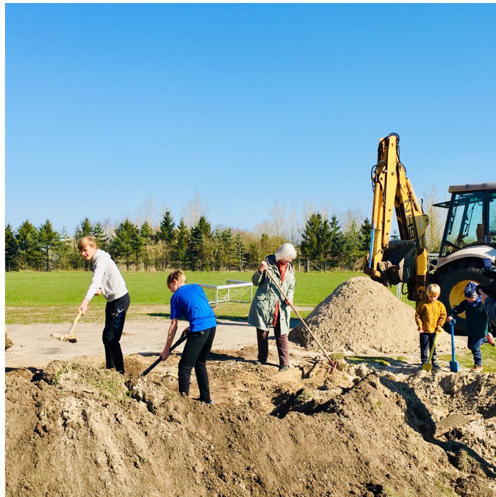
Udgravning til klatretårn – 4 generationer.
