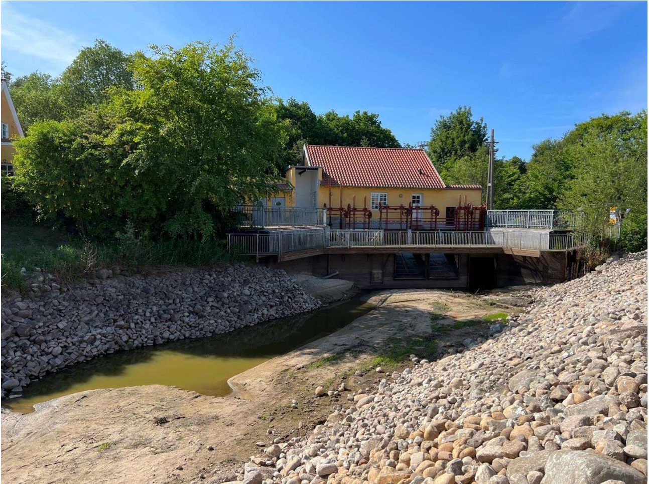
Der skal laves fri passage af vand i Uggerby Å. Foto den 9.juni 23
