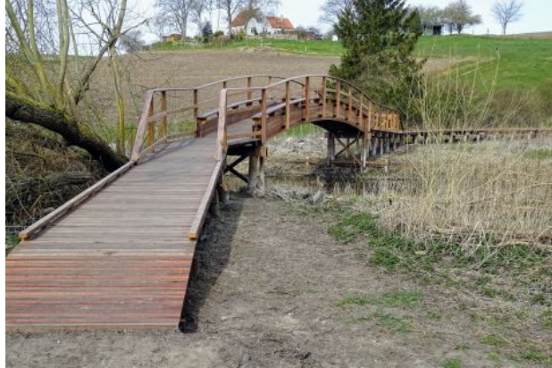
Broen/spangen over Susåen set fra Næstved (Næsby) siden. Flot konstruktion.
